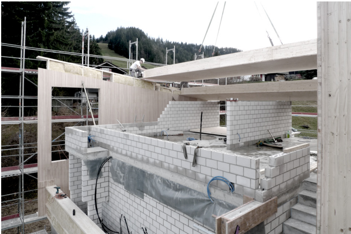
Montage der Holzelemente um den massiven Kern
