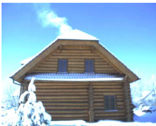
Pohled na štítovou stěnu objektu
