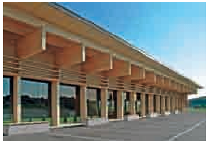
Víceúčelová hala La Brillanz ve francouzském Lentigny. Lepené nosníky i vnější plášť budovy chrání masivní střešní přesah jako prvek konstrukční ochrany dřeva
