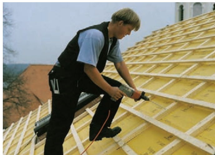
Řešení nadkroevního systému z exteriérové strany
