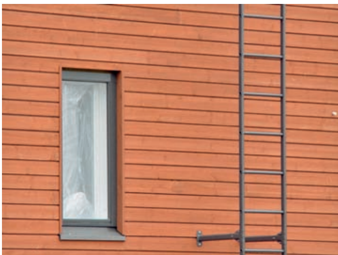
Horizontálně kladená fasádní prkna spojená systémem drážka – pero. Úzké ostění okna v barvě fasády vytváří opticky nerušený solidní přechod k tmavě provedenému osazení okna
