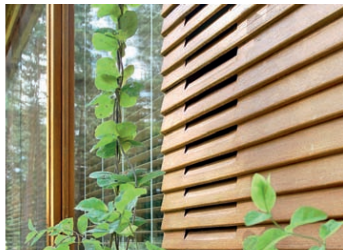
Překrývaný obklad z hoblovaných zaoblených lakovaných dubových palubek na obytném domě ve finském Noormaku (architekt Alvar Aalto, 1939). Zvláštní efekt spočívá v dodatečném lamelování v oblasti okna. V odpovídající interiérové části jsou instalovány větrací klapky
