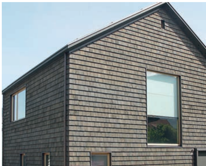
Moderní šindelová fasáda z řezaných šindelů natřených šedým lazurovacím lakem. Farní centrum Bonaduz, Graubünden, Švýcarsko, architekt Walter Bieler
