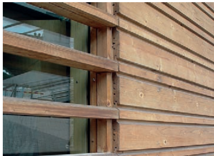
Horizontální obložení, spojení na polodrážku, se dvěma různě širokými profily. Lamely s úzkým profilem jsou vedeny i v místě okna průběžně dál, aby byla výtvarně zdůrazněna horizontální struktura fasády
