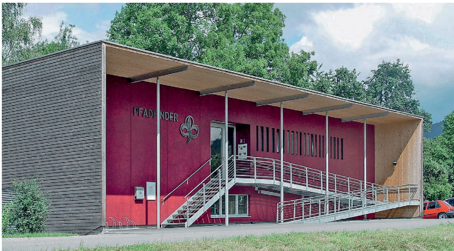
Skautská ubytovna ve Wolfurtu, Vorarlberg, Rakousko (architekt H. Kaufmann). Galerie je koncipována se záměrem povětrnostní ochrany. Přesah střechy v průčelí chrání barevnou fasádu z OSB desek. Současně chrání objekty schodiště a rampy. Ostatní části fasády bez střešních přesahů (boční stěny) jsou vědomě vystaveny působení počasí, což vytváří stejnoměrnou patinu zešednutí
