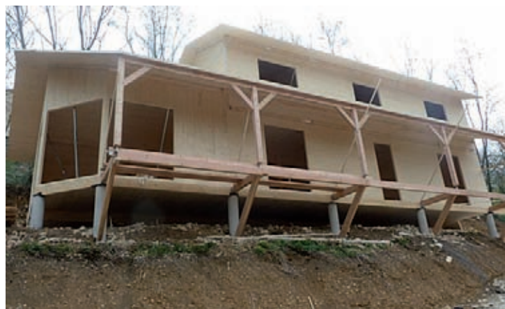
Dům na betonových patkách, celodřevěná konstrukce NOVATOP vč. podlahy.
