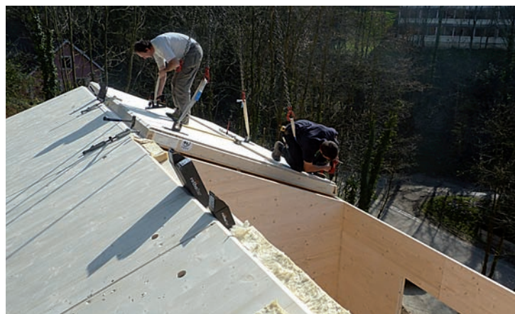
Montáž šikmé střechy s použitím žebrových panelů NOVATOP ELEMENTS.
