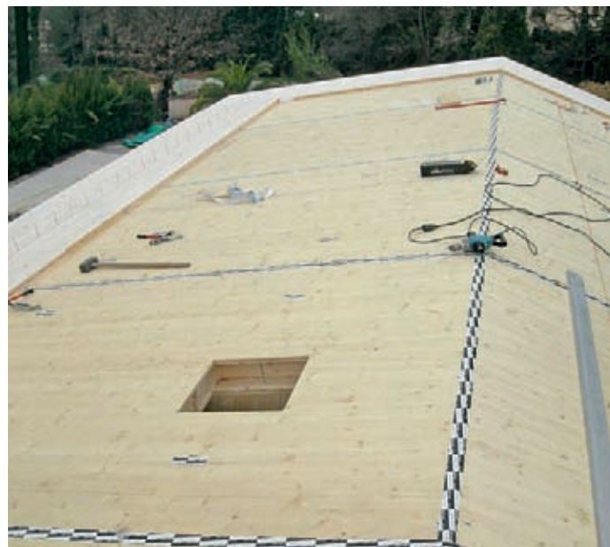
Zajištění vzduchotěsnosti na příkladu velkoplošných žebrových komponent NOVATOP ELEMENTS – přelepení spár a výsprav po sucích speciální vzduchotěsnou páskou Foto NOVATOP
