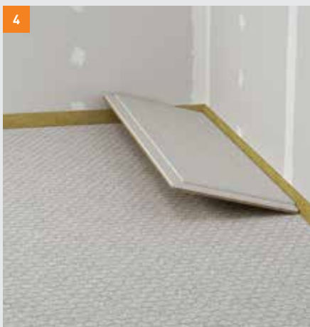
Pokládka podlahových prvků fermacell
