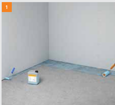
1 Penetrace podkladu hloubkovou penetrací fermacell
