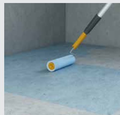
Příprava: penetrace podlahy
