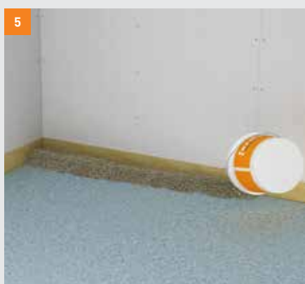
5 Připraví se první břeh pro stahovací lat
