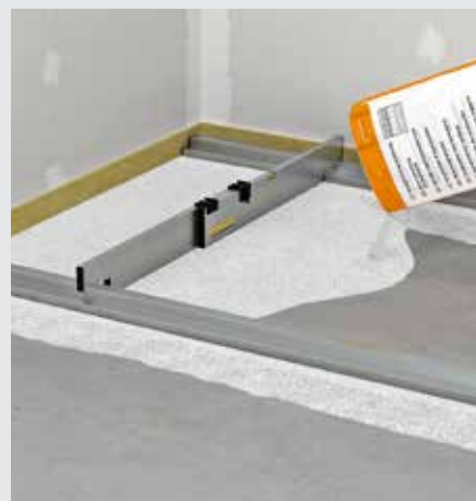
Aplikace vyrovnávacího podsypu
