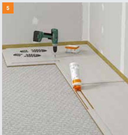
Spojování jednotlivých podlahových prvků fermacell
