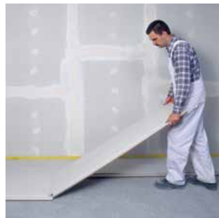
Pokládka akustické desky fermacell Silentio
