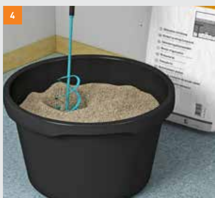
4 ... pomocí vhodného míchacího zařízení
