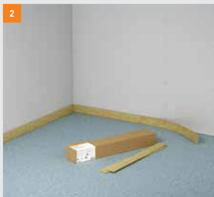
2 Upevnění okrajových izolačních pásek
