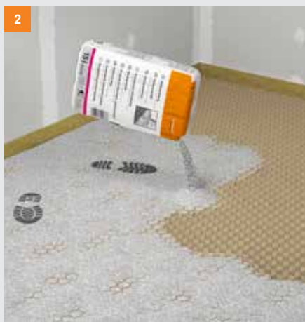
2 Aplikace voštinového zásypu fermacell
