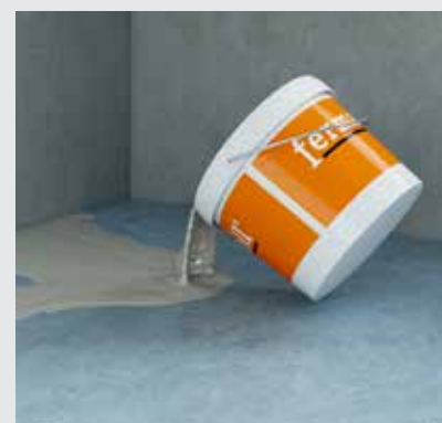
Nivelační hmotu vylijte a vyrovnajte
