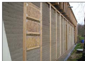
4c Dokončené hliněné výplně před zateplením
