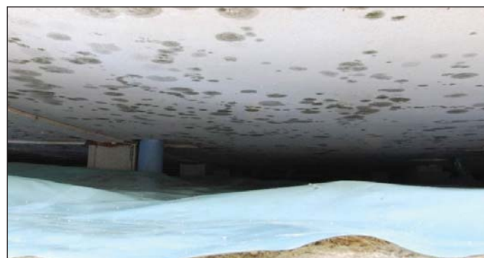
1b Plíseň na spodním záklopu podlahy ze sádrovláknitých desek
