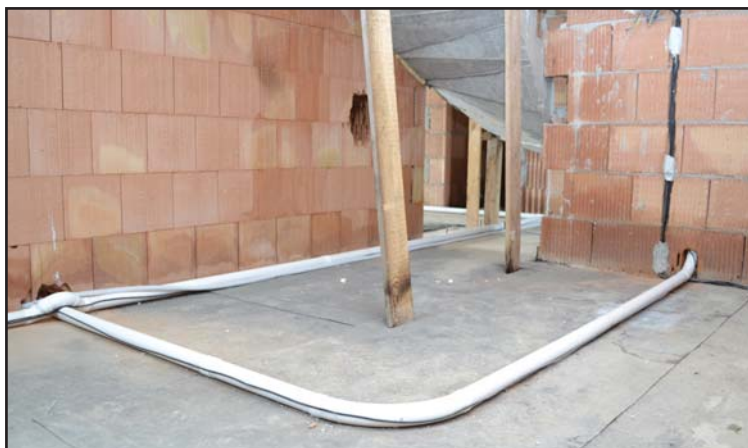
Fotografie z pokládky potrubí a zásuvek v hrubé stavbě.
