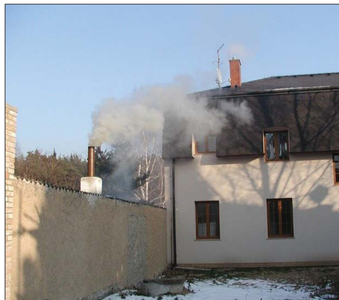
Nízko vyvedený komín sousední budovy odvádějící spaliny spotřebiče na pevné palivo. Dochází k obtěžování a znečišťování spalinami u sousední vyšší budovy. Komín je nutné zvýšit.
