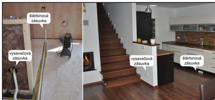
Ukázka montáže v dřevostavbě
