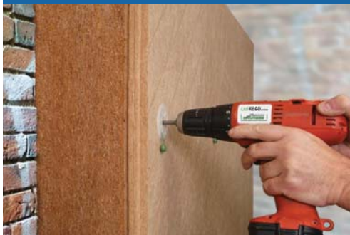
Vnější izolace objektu dřevovláknitými deskami Udí a vytvoření funkční odvětrávané fasády
