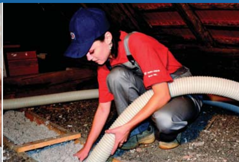
Foukání Climatizeru Plus® v podkroví
