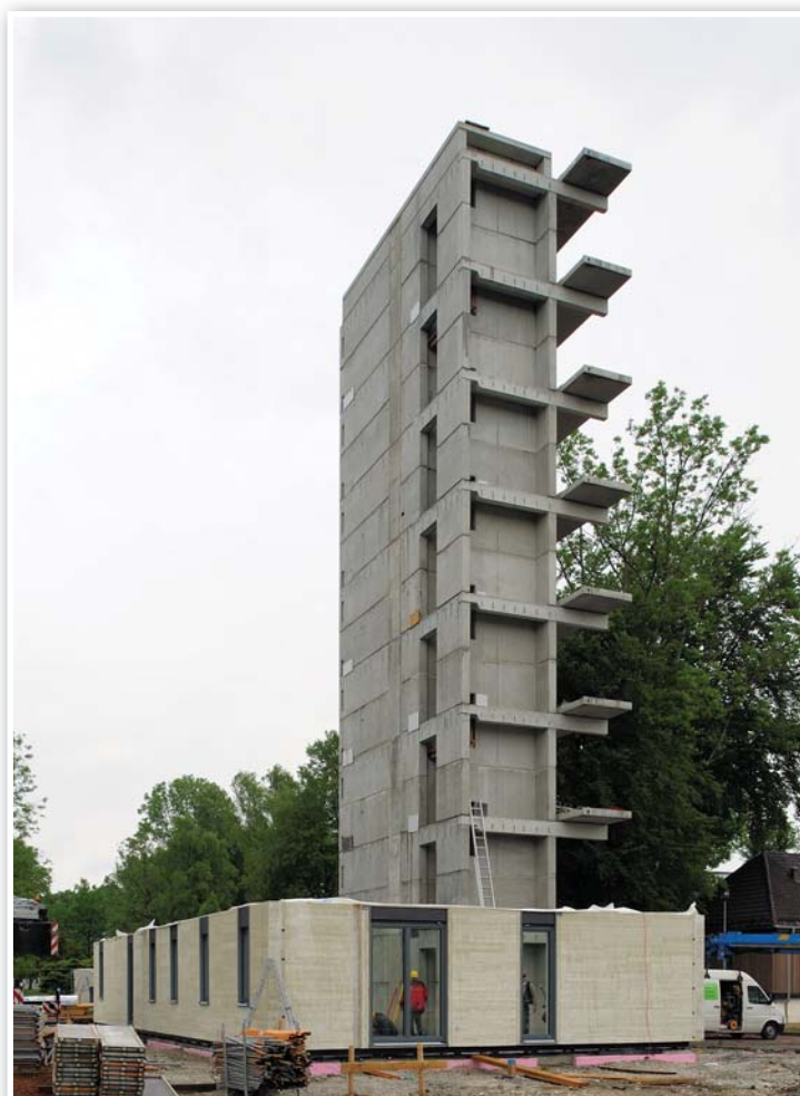
Výhody spojení dvou technologií – nosné železobetonové konstrukce a prefabrikovaných fasádních prvků – se uplatnily i při výstavbě osmipodlažního, 25 metrů vysokého objektu v Bad Aiblingu
