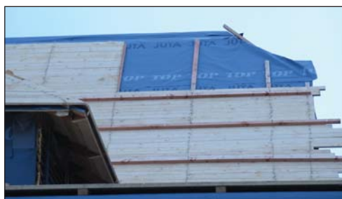
Foto 5 (membrána JUTATOP 2AP na střeše)
