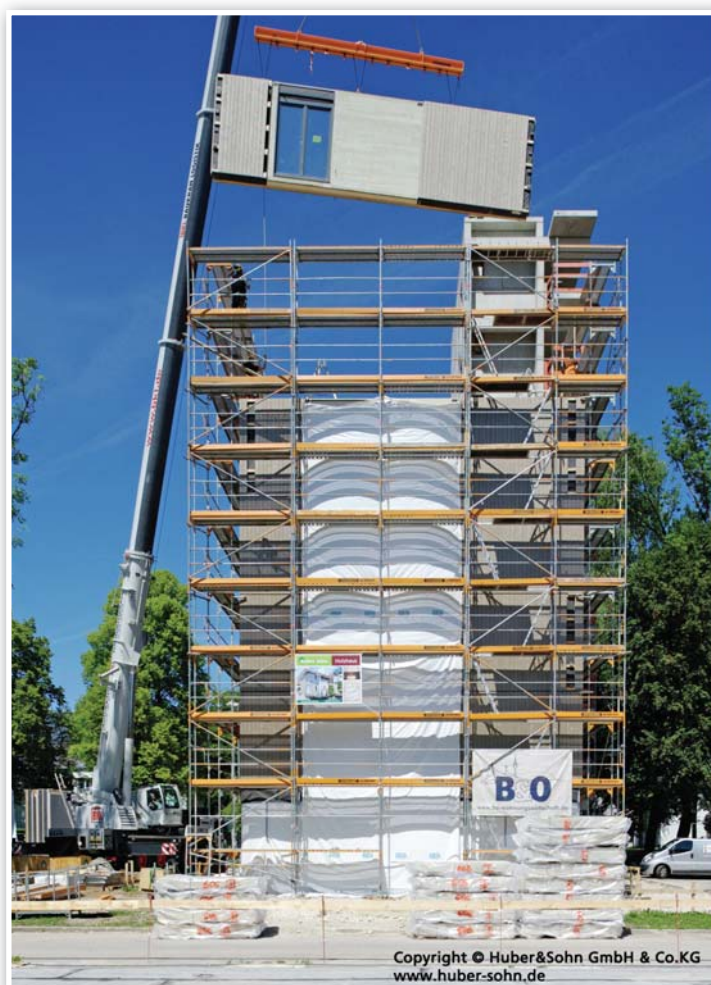
Výhody spojení dvou technologií – nosné železobetonové konstrukce a prefabrikovaných fasádních prvků – se uplatnily i při výstavbě osmipodlažního, 25 metrů vysokého objektu v Bad Aiblingu
