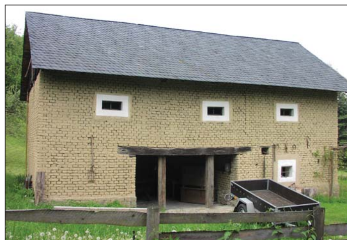
3 Hliněný dům s dřevěnými překlady, průvlaky, stropem a střechou
