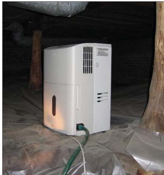
2b Odvhčovač v průlezném prostoru. Foto Inspectapedia
