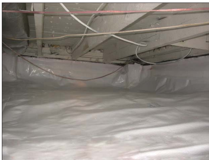
2a Zapouzdření průlezného prostoru. Foto Inspectapedia
