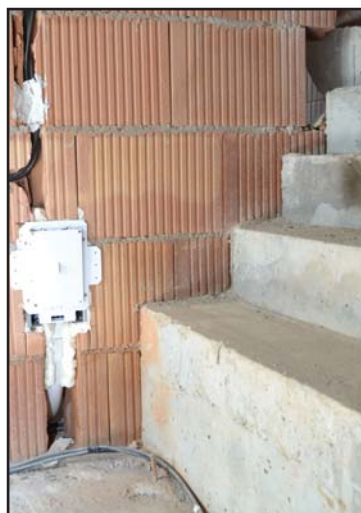
Fotografie z pokládky potrubí a zásuvek v hrubé stavbě.
