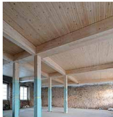
Kolíkovaný dřevěný strop po dokončení montáže při rekonstrukci radnice a knihovny v Karšašově Řečici
